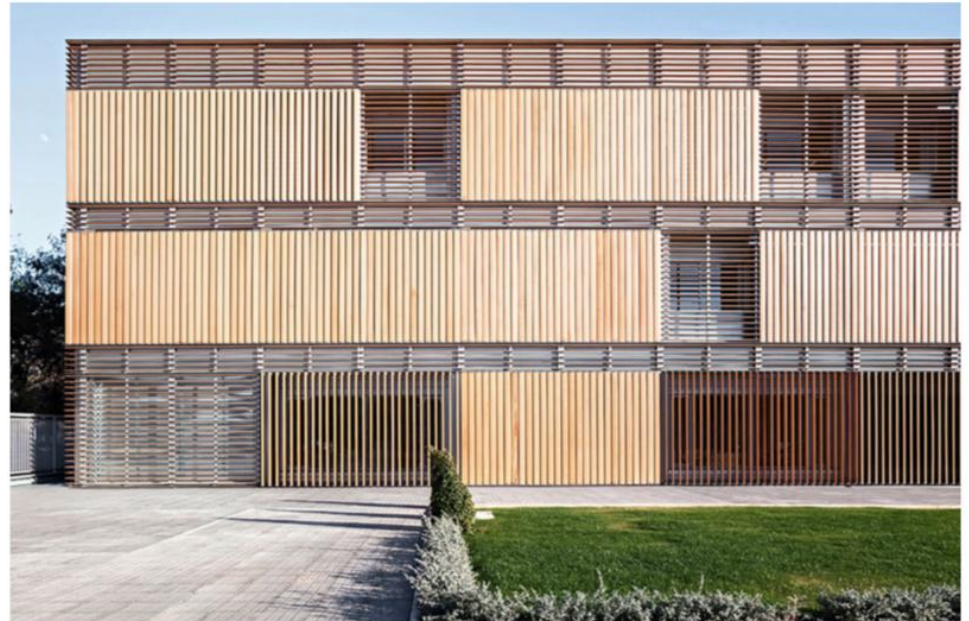
Im Westblock des Centre d'Idiomes de la Universitat de València des Architekturbüros Arkitera SLP bestimmt die Kombination von feststehenden und beweglichen Sonnenschutz-Lamellen die Fassadenstruktur.
