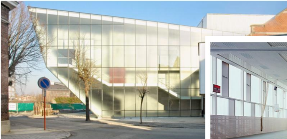
Eine Fassade aus strukturiertem und mattem Glas sorgt für ausreichend Tageslicht im Gebäude, und gezielt nur dort zum Einsatz kommen, wo ein Ausblick gebraucht wird. Am Théâtre le Manège d'Architecture Pierre Hebbelinck mit diesem spannenden Mix aus verschiedenen Glasstrukturen.
