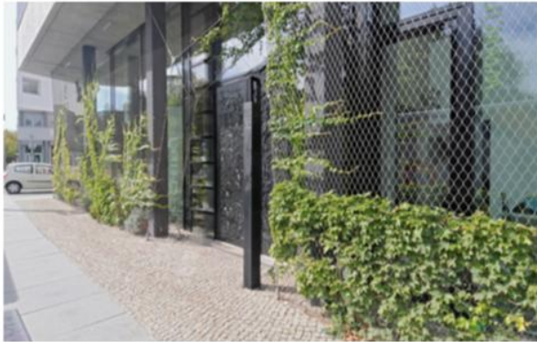
Stahlnetze, wie sie häufig zur Gebäudebegrünung genutzt werden, können bei
