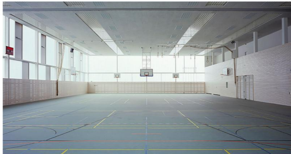
Die Gebäudehülle der Ballspielhalle Ingolstadt von Fink+Jocher besteht aus einer Profilbauglaskonstruktion, die zwischen ihren beiden Glasprofilschalen mit transluzenter Wärmedämmung gefüllt ist. Diese sorgt für ausreichend Lichteinfall ohne störende Schlagschatten auf dem Spielfeld.
