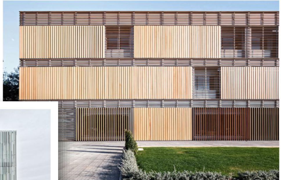
Die Fassade der Bibliothek der Universität de València des Architekturbüros Arkitera SLP bestimmt die Kombination von feststehenden Holz-Lamellen die Fassadenstruktur.
