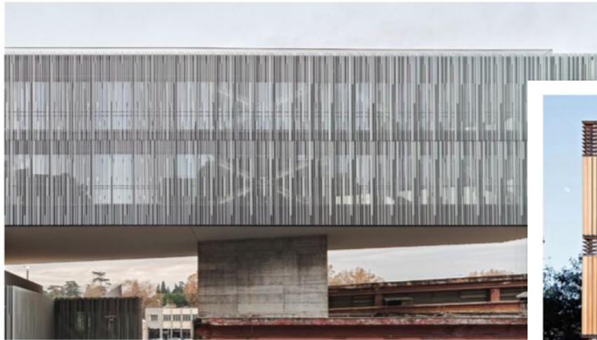
Die Città del Sole («Sonnenstadt») in Rom des Architekturbüros Labics ist eine Mehrzweckanlage mit öffentlicher Nutzung. Sowohl die Fassadengestaltung aus Aluminiumprofilen als auch die transluzenten gläsernen Lamellen an der Fassade sorgen gleichermaßen für Sonnen- wie auch für Vogelschutz.
