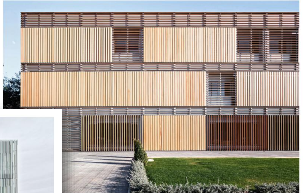
Die Fassade der Bibliothek der Universität de València des Architekturbüros Arkitera SLP bestimmt die Kombination von feststehenden Lamellen und durchsichtigen Lamellen die Fassadenstruktur.
