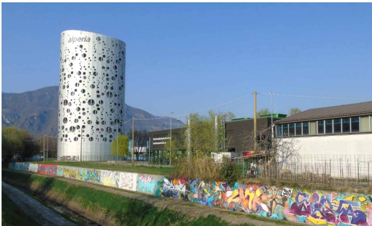
Figura 20 – L'impianto di teleriscaldamento di Bolzano fornisce calore a decine di migliaia di famiglie.
