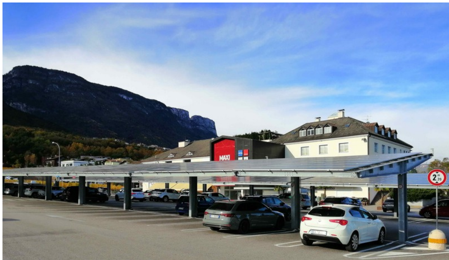
Figura 22 – Un parcheggio attrezzato con impianto fotovoltaico ad Appiano
